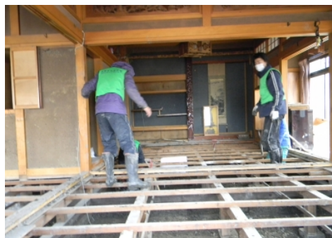
津波で浸水、一度床板をはがして清掃
