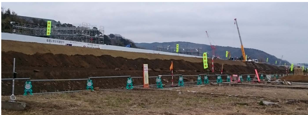
津波被害の大きかった地域では、大規模なかさ上げ工事や災害公営住宅の建設が進行中。 (写真は、2016年3月 宮城県石巻市門脇地区) ※災害公営住宅の完成が、平成30年度(2018年度)以降になる地域もあります。
