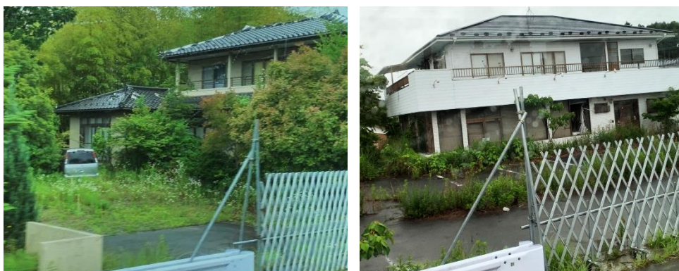
道路沿いの敷地入り口には全てバリケードが張られている
