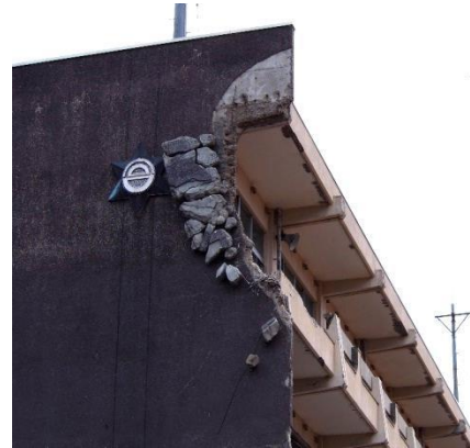
写真左：旧気仙沼向洋高校屋上の真下4階の壁。近隣の工場が激突した跡。 写真右：五十鈴神社の鳥居。多くの人がこの神社に逃げて助かった。
