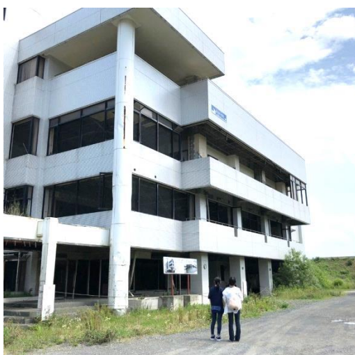
高野会館（3階壁に津波到達線の表示！）
