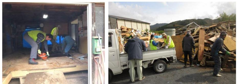
床板を切って剥がし、床下の泥出しを行う 選別した廃棄物を仮集積所へ運搬
