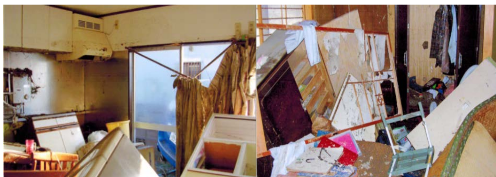
天井近くまで水に浸かった台所
