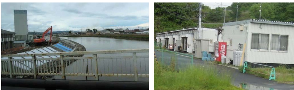
堤防工事の場所や未だ残る仮設住宅が見られました
