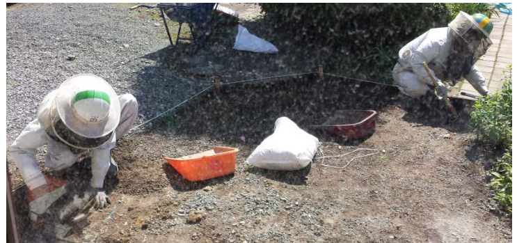
局所除染 手作業で土を剥いでいく様子
