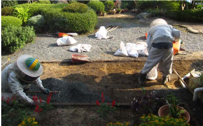
局所除染 手作業で土を剥いでいく様子
