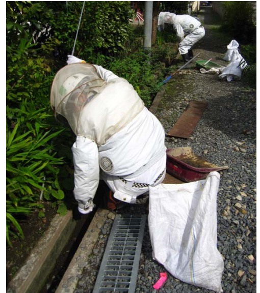
側溝除染も手作業で行われている。
