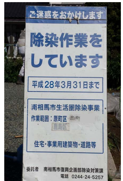
除染作業場所には、きちんと看板が設置されている。
